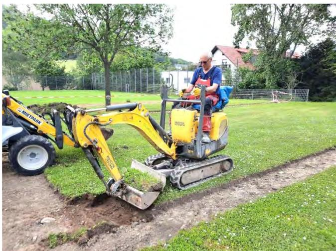
Am 05.06. ging es dann wirklich los mit dem schweren Gerät! Zuerst wurden 10 LKW-Ladungen (über 100 Tonnen) Material abgefahren, dann ein Vlies verlegt und danach Sand von 4 LKW-Zügen verfüllt.
